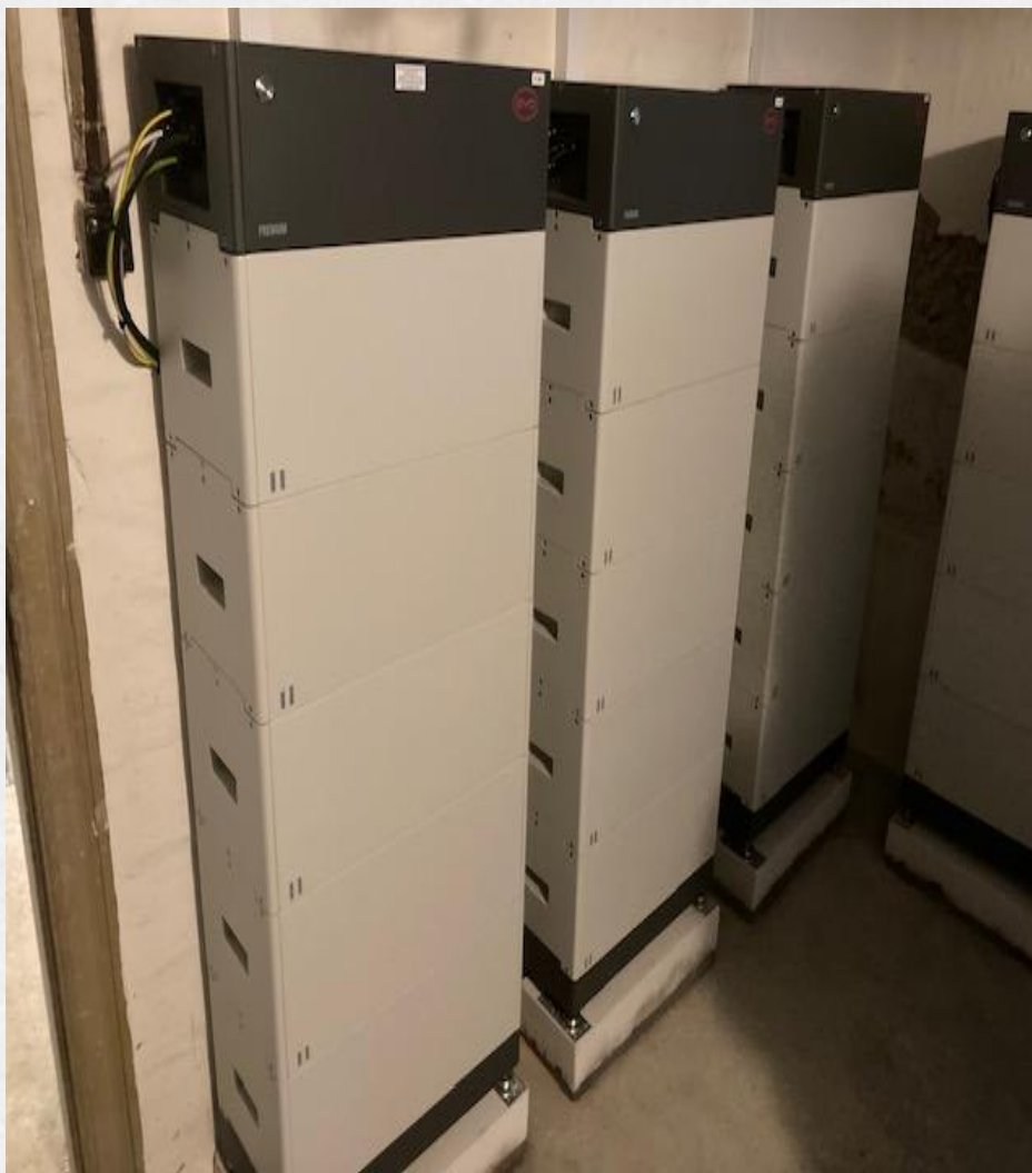
198 KW BYD batterier opsat AB Strandlodsgården København 4. kvartal 2024 + 12 x 10 KW invertere. 153 KWp solceller på vej op
