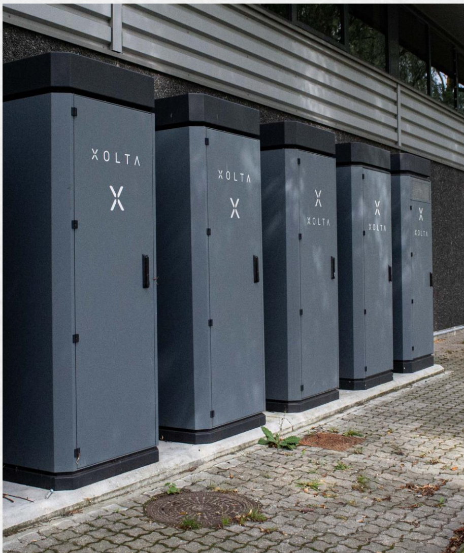
400 KW/300 KW invertere XOLTA batterier Skovlunde
